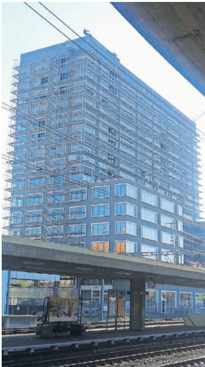
Knacken im Fenster: Der «Westlink» beim Bahnhof Altstetten wurde eingerüstet. TMA
